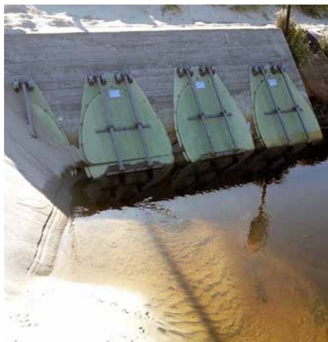
Graveklapper på 4 styk Ø1000 udløb ved Sola Lufthavn, Stavanger.
