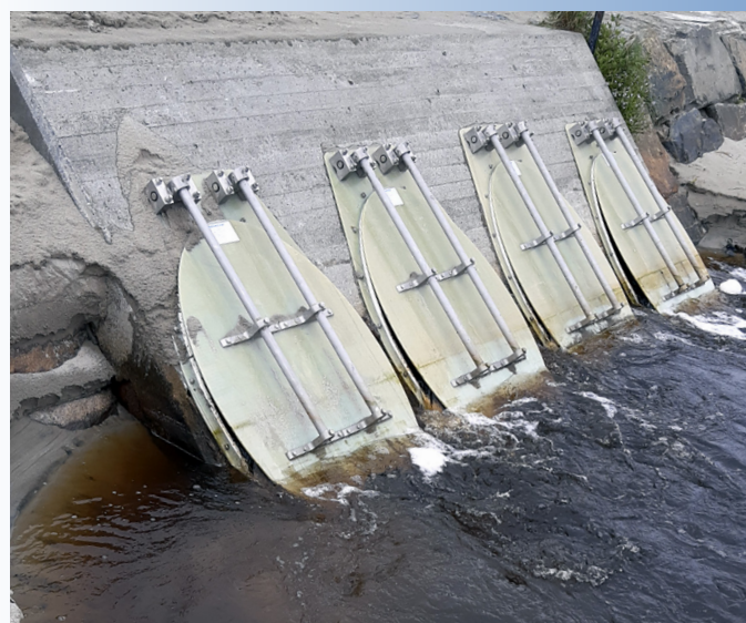
Graveklapper på 4 styk Ø1000 udløb ved Sola Lufthavn, Stavanger. Udført for det norske Statens Vegvesen.
